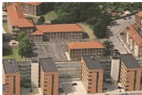
Det Nationale Center for Registerforskning ligger i bygningen mellem Teologi – det tidligere Ortopædisk Hospital – og Nobelparken.
